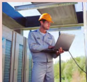
És una solució avançada de software que facilita la posada en marxa del sistema en menys temps, mitjançant un connector USB a la unitat condensadora. D'aquesta manera es facilita i agilitza la configuració i ajust en la pròpia obra ja que es pot connectar l'ordinador a la unitat directament. Amb aquesta configuració es poden carregar en totes les unitats de la instal·lació, simplificant el temps de posada en marxa.
